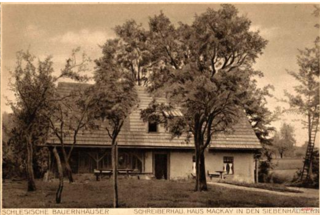
SCHLESISCHE BAUERNHÄUSER SCHREIBERHAU, HAUS MACKAY IN DEN SIEBENHÄUSEN
