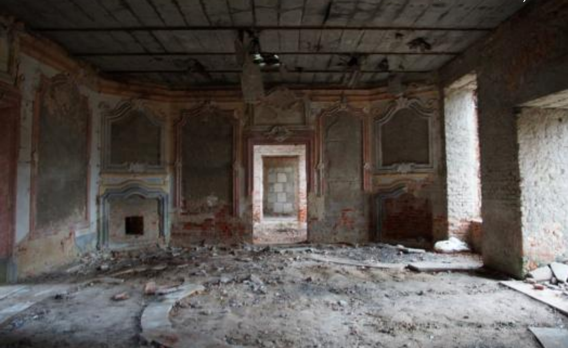
Wnętrze pałacu Kospothów. Na górze widać fragment naprawianego niedawno stropu fot. Dawid Gawlik, 2018
