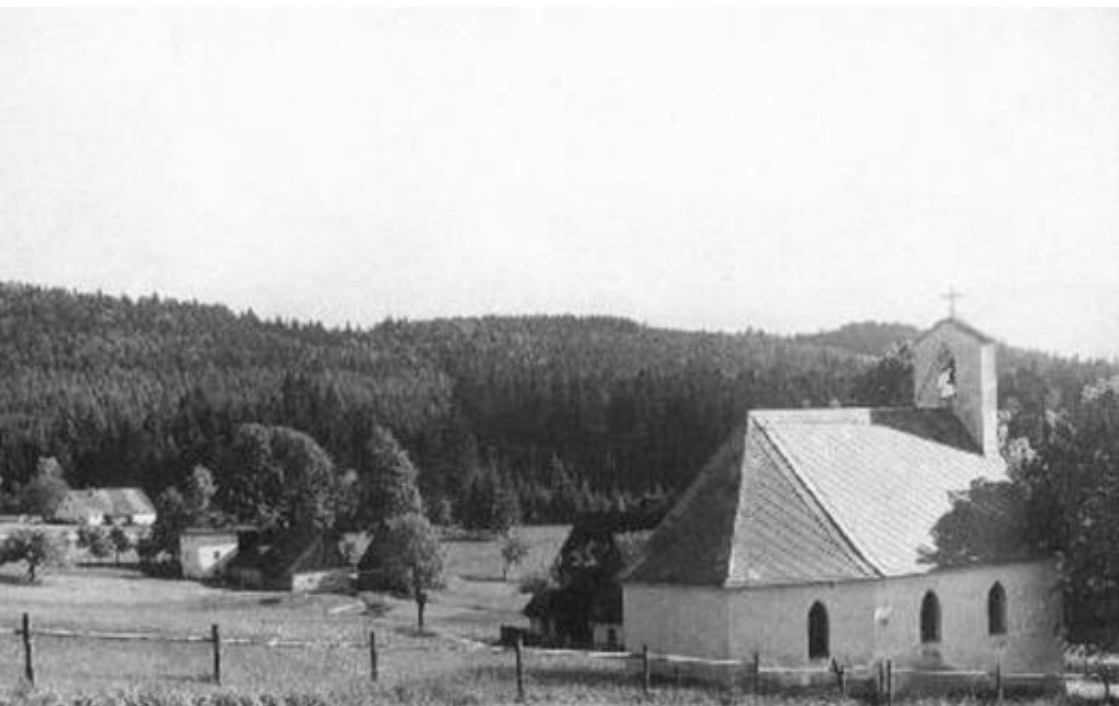
Wieś Karpno, po prawej kościół (obecna kaplica) fot. autor nieznany, okres międzywojenny
