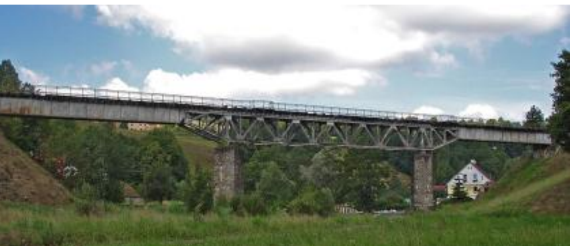
Wiadukt w wałbrzyskiej dzielnicy Podgórze, tuż za stacją Wałbrzych Główny. fot. archiwum Starostwa Powiatowego w Wałbrzychu
